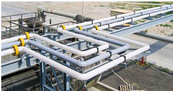
Slika 5 Cevovodi sa lirom kao kompenzatorom
