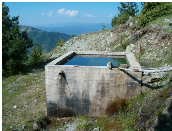
Слика 20. Водозахват на подручју Студене планине димензија 4x3x2 м
