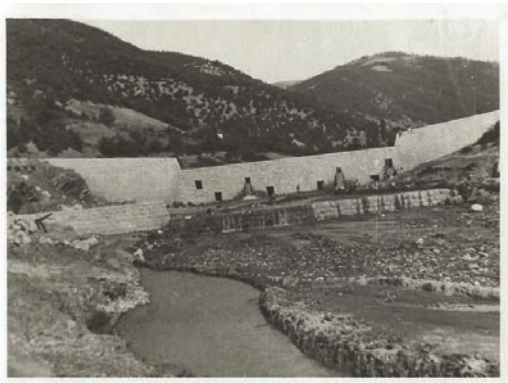
Слика 4. Прва наша „ретардациона преграда“ изграђена у кориту „Врањско – бањске реке“ 1951. г. допринела је смањењу разорности бујичних поплава и смирила урвинске процесе.
