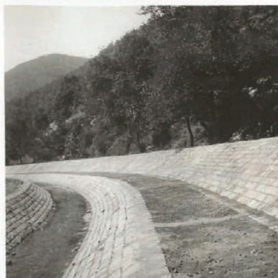
Слика 6. Правилно пројектована и изграђена регулација корита бујичног дела р. Јабланице кроз Сијаринску бању. Пројектант инж. Сава Стефановић, извођач Секција за бујице Ниш.
