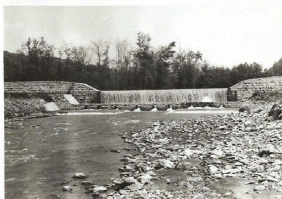
Слика 5. Специјална бујична преграда изграђена 1963. г. у подручју Лознице, по пројекту инж. Бориса Мамонтова, снажно је допринела умањењу снаге бујичног тока.
