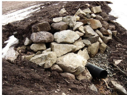
Слика 8 Стабилизационо-дренажна конструкција (излив; ски-стаза „Коњарник 1“, Октобар 2008) Figure 8 Stabilization and drainage construction (outflow; ski run Konjarnik 1, October 2008)
