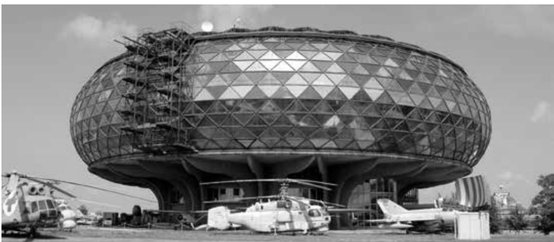
Прилог 36. Музеј ваздухопловства у Београду, Иван Штраус , изграђен по конкурсном решењу из 1969. године
