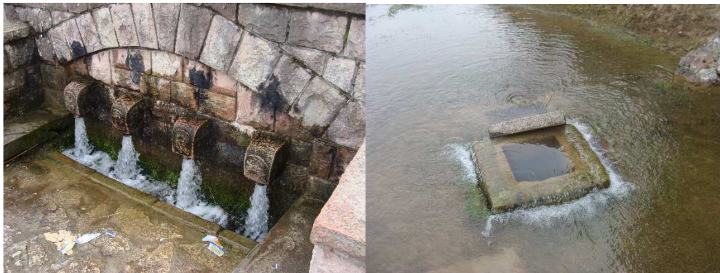
Slika 6.4. Levo: kaptirano vrelo u vidu česme; desno: isticanje voda za vreme velikih voda
