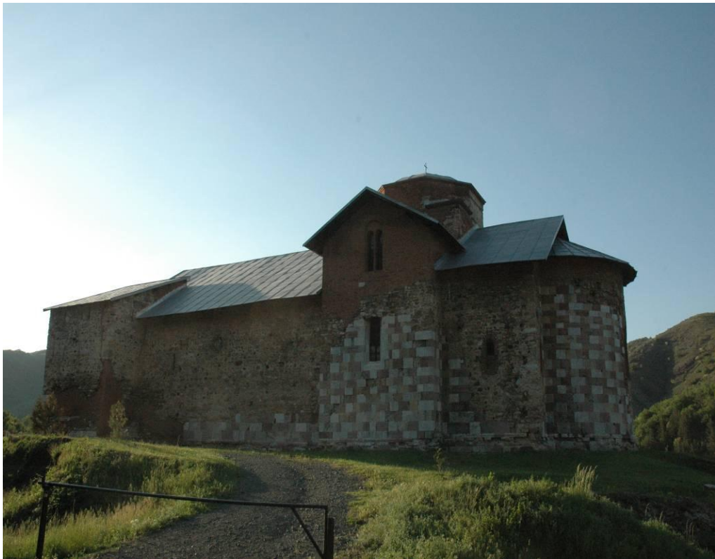
Сл. 22. Поглед са јужне стране на цркву Св. Стефана
