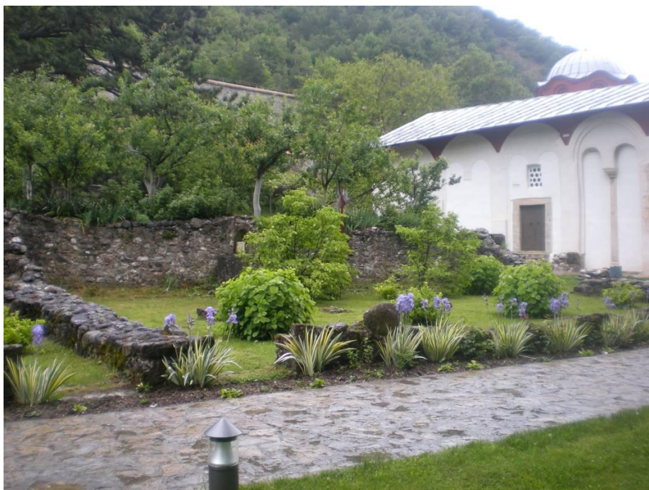
Сл. 73. Део западне стране припрате и остаци грађевине испред ње
