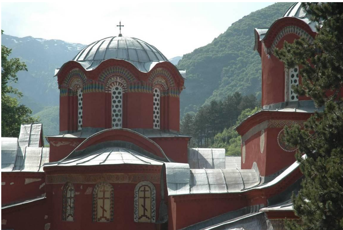
Сл. 52. Купола Богородичине цркве, Св. Апостола и слепи прозори посматрани са источне стране
