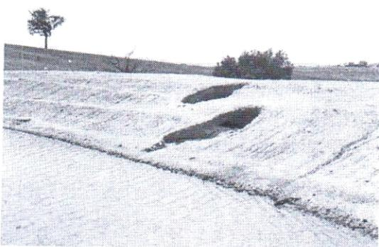
**Slika 1.2.** Oštećenja kosine nasute brane izgrađene od disperzivnih glina (Fell.R, Soil Conservation Service of NSW)
