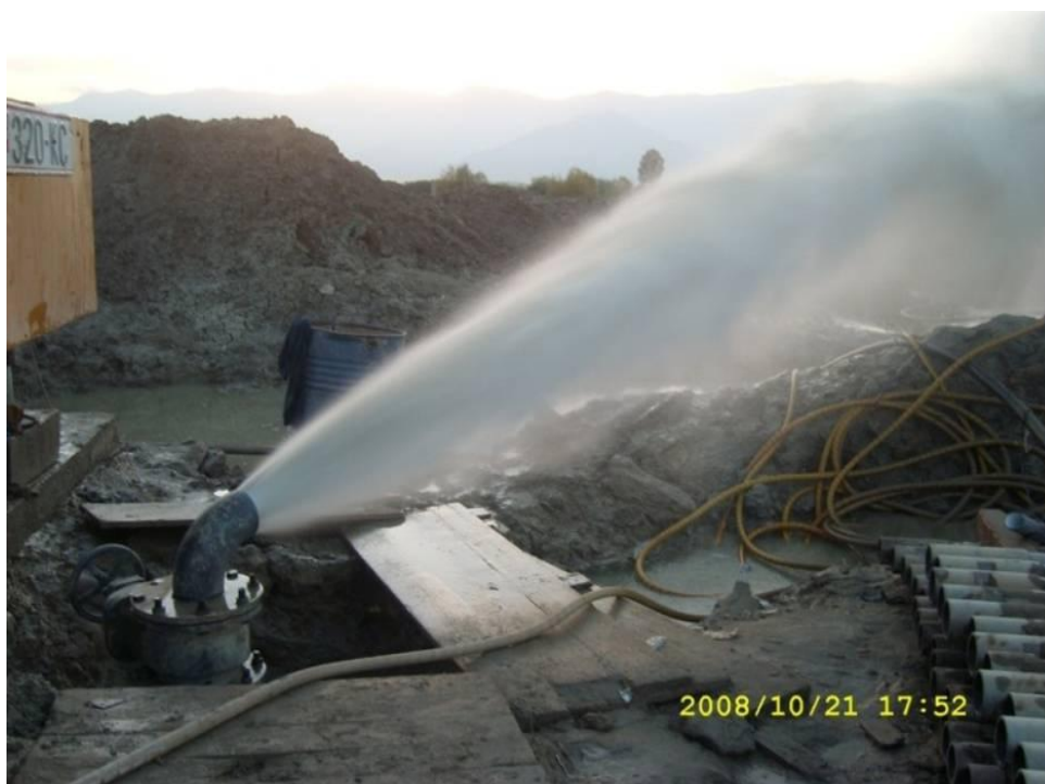
Slika 2.8. Samoizliv mineralne vode praćen erupcijom gasa CO 2 (novouzvedena bušotina B-7a/2008 za potrebe sanacije havarisane bušotine B-7/2008, Foto: D. Petrov)
