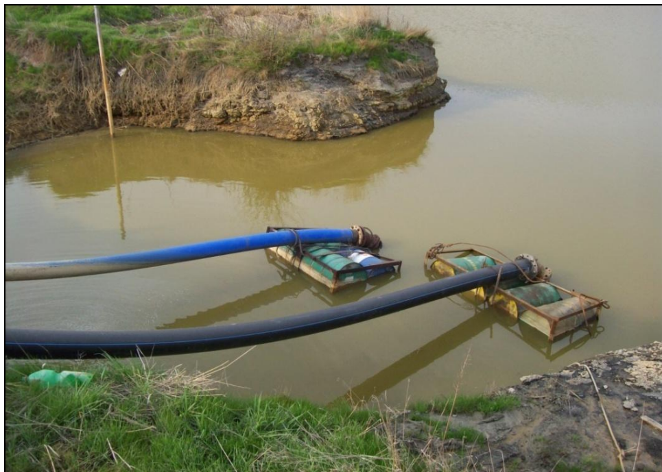
Slika 5.48. Centralni vodosabirnik u površinskom kopu „Suvodol“ (Foto: Boševski, 2011)
