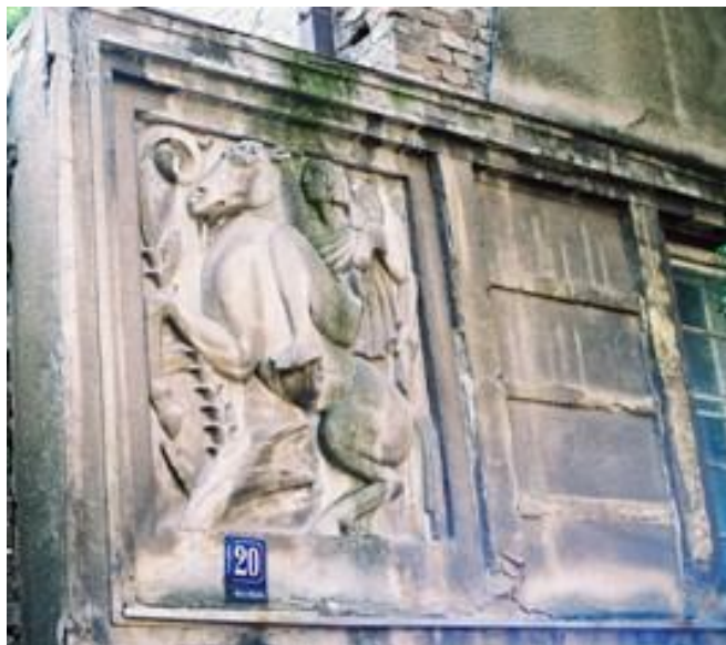
Сл. 866 1933. Војводе Богдана 20 (порушена) (фото М.Јуришић)
