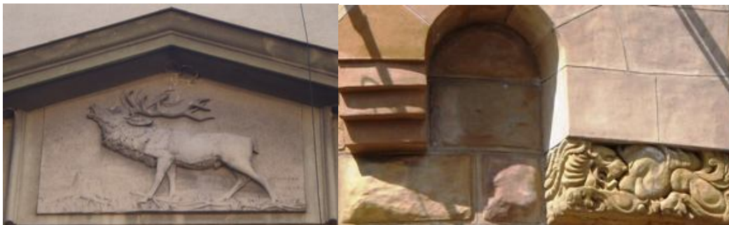
Сл. 361,362 Нови Сад Јована Ђорђевића 4, Мост Краља Александра (терен)
