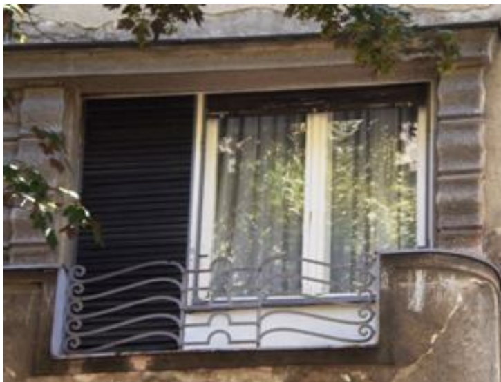
Сл. 1134 1938. Авалска 6 балкон (терен)
