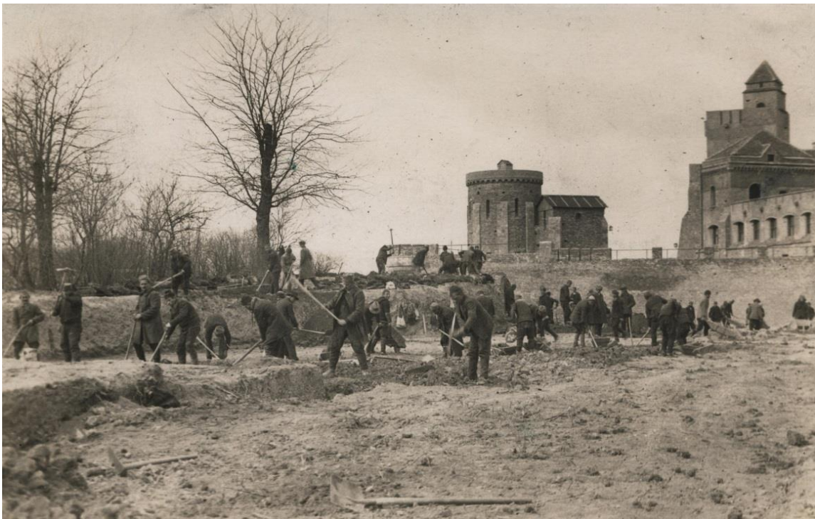
Сл. 47 – Радови на реконструкцији Великог Калемегдана (Колекција М. Јуришића)
