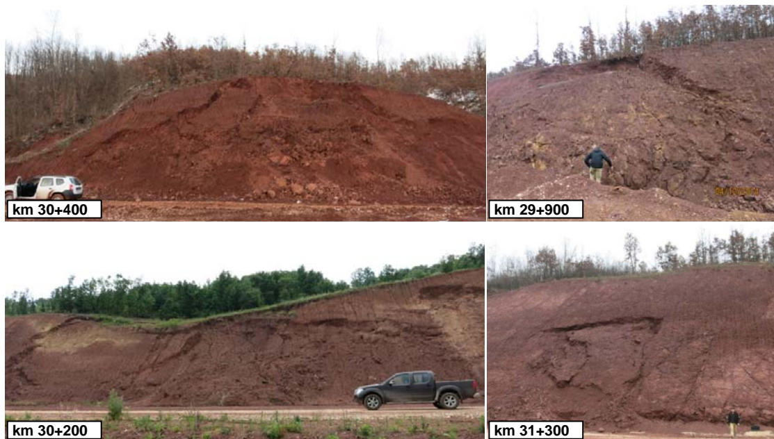
Slika 7.5 Karakteristične nestabilnosti u permskim sedimentima
